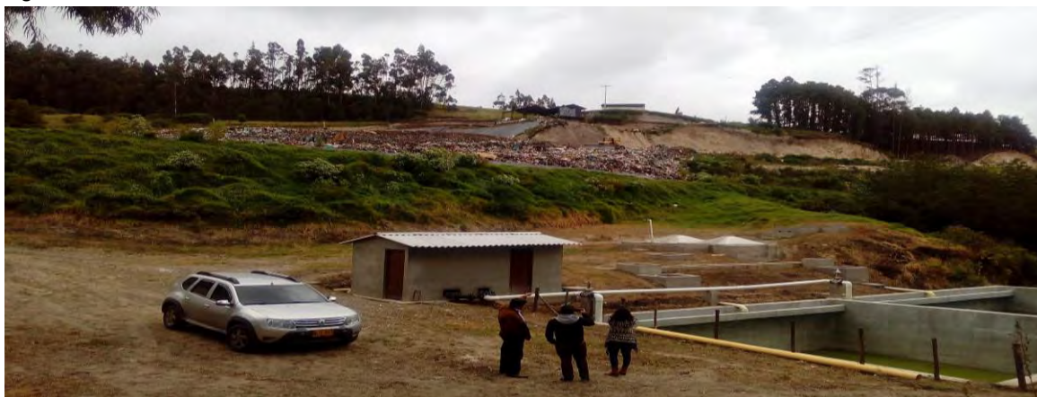
Figura 18. Relleno Sanitario La Victoria
