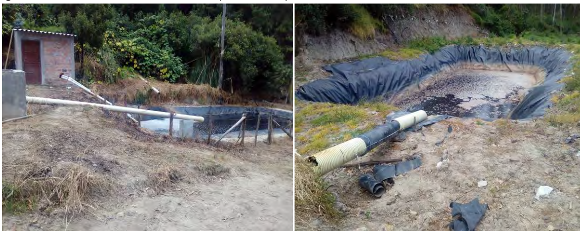
Figura 19. PTL de Recirculación Actual (Funcionado)
